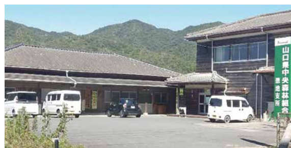
現在の徳地支所（昭和56年建設）
